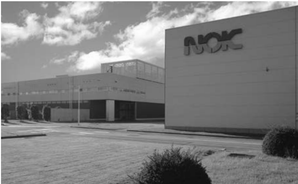
NOK オイルシール事業部 福島県福島市永井川字統堀8番地
